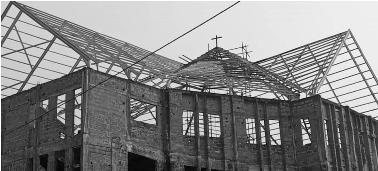
Kyrkbygget i Kinshasa pågår.
